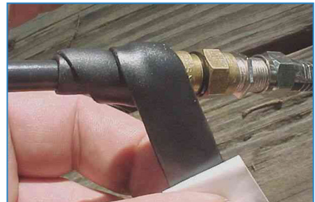
Una vez aplicada la cinta, esta comenzará un proceso de autovulcanización convirtiéndose en una masa compacta aislante.
