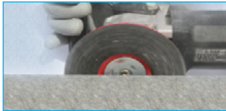
Desbaste y nivelación sobre cemento y hormigón.
