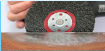
Eliminación y limpieza de óxido, pinturas, barnices, revestimientos y adhesivos.
